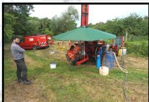
Des travaux de carottage ont été réalisés dans le but d'analyser la consistance des sols en vue de l'installation prochaine d'une passerelle qui viendra enjamber le bras de Seine. Cette passerelle permettra alors d'emprunter les chemins de randonnée de Saint Aubin les Elbeuf jusque Sotteville sous le Val. L'installation est prévue sur 2026.
